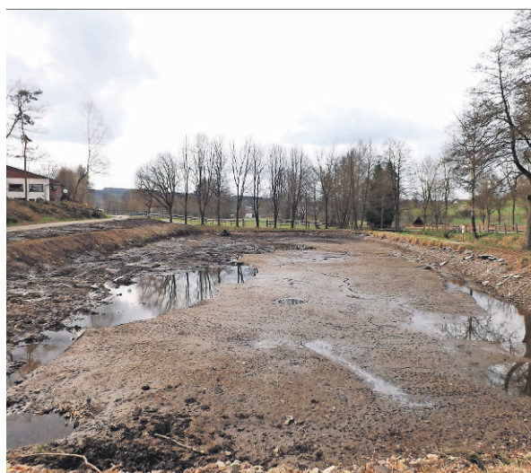
Die VoG hat den kleineren Weiher im Eingangsbereich komplett trockengelegt und ausgebagert.
